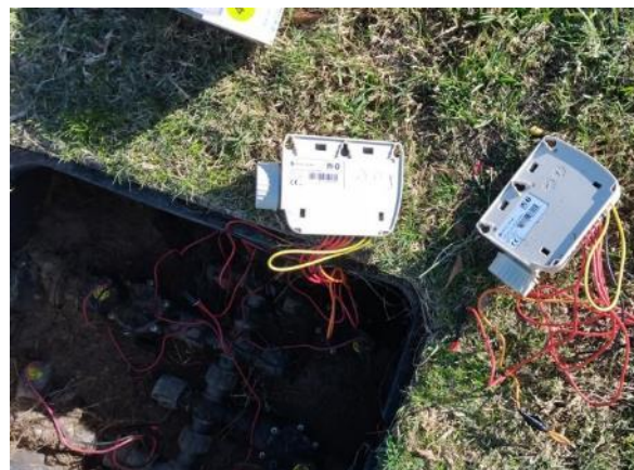
Rotonda Fase 6 (programador Solem nuevo No funciona; se cambia por otro) NO CONTABILIZA
