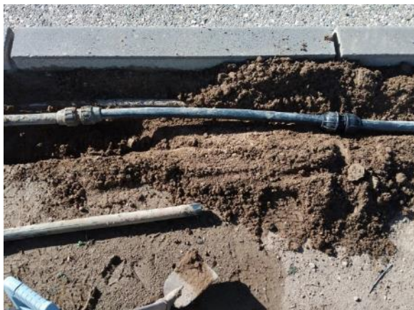
Vial ppal. mediana frente campo fútbol (1 ml PE Ø32 y 1 enlace)
