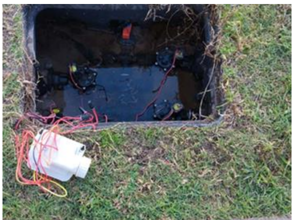
Rotonda Fase 1 (cambio programador Solem 4 estaciones)
