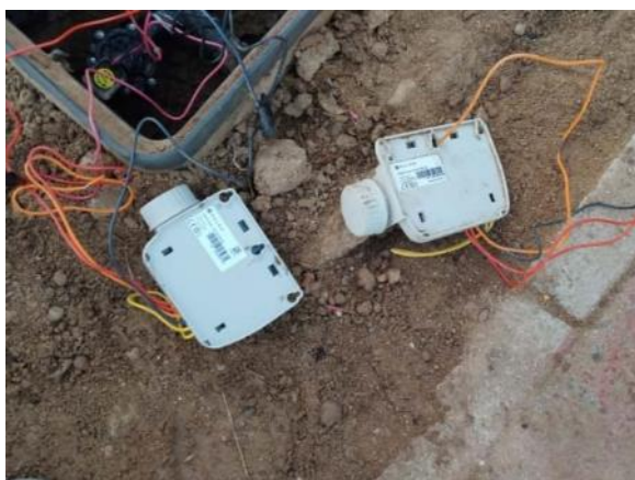
Vial ppal. dcha. frente hotel (cambio de programador Solem roto por Solem Nuevo)
