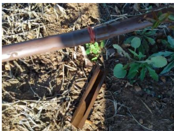
Mediana vial ppal. (4 roturas en PE Ø16-enlaces)
