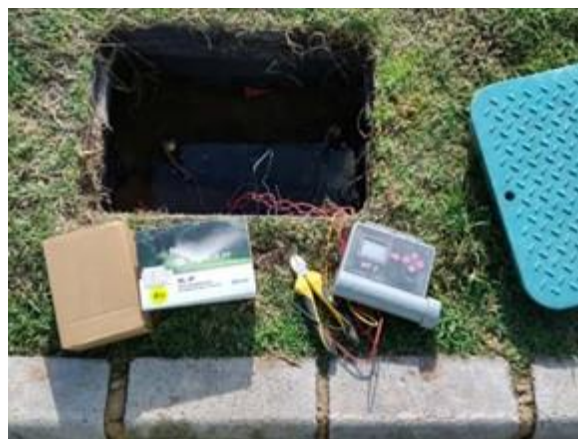
Rotonda Fase 1 (cambio programador Solem 4 estaciones)
