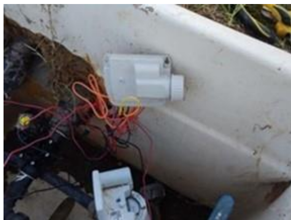
Rotonda Fase 6 (cambio programador Solem 4 estaciones y 1 electroválvula 1")
