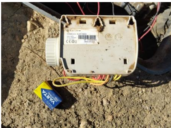
Vial ppal. dcha. frente hotel (cambio pila)
