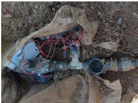
Vial ppal. dcha. altura hotel (cambio electroválvula)
