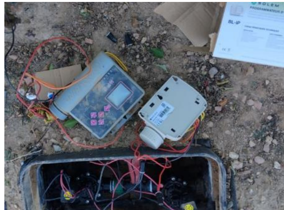
Vial ppal. dcha. junto Campo Fútbol (cambio programador RainBird roto por uno Solem Nuevo)
