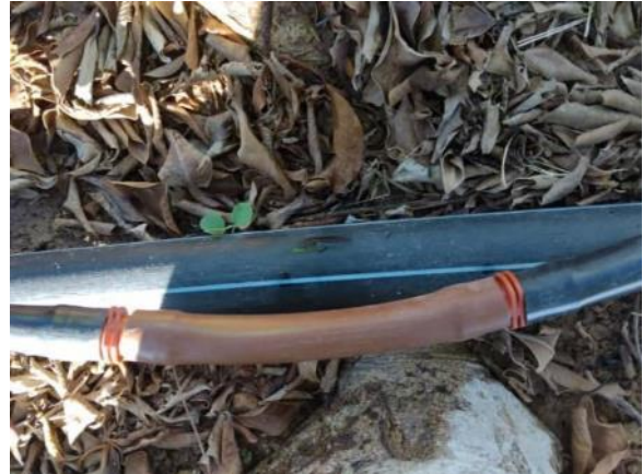
Vial ppal. margen izq. (9 roturas en PE Ø16- 0,5 ml tubería y 2 enlaces)
