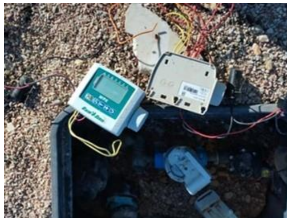
Rotonda final C/ Bahamas (cambio programador RainBird roto por Solem usado)
