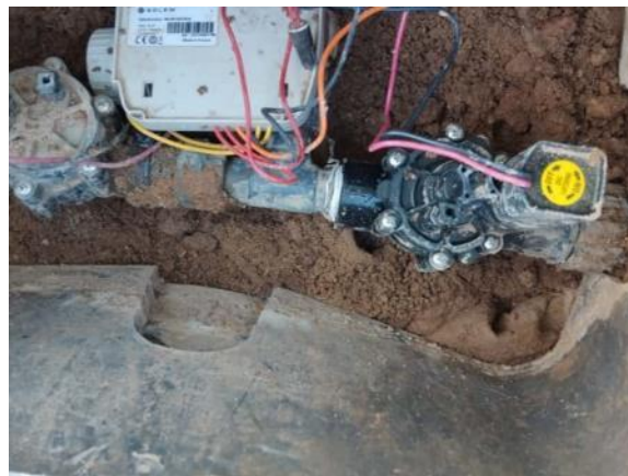
Vial ppal. dcha. altura hotel (cambio electroválvula)
