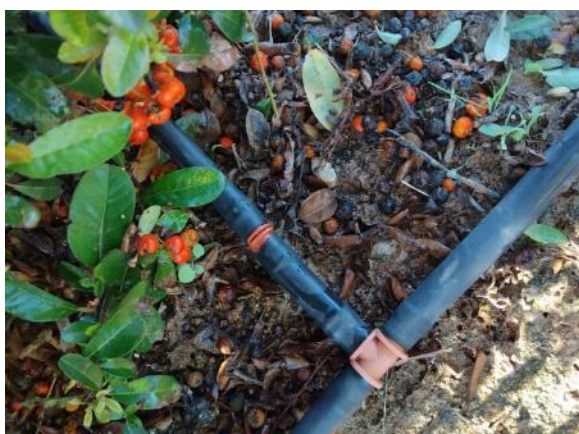
Mediana vial ppal. (4 roturas en PE Ø16-enlaces)
