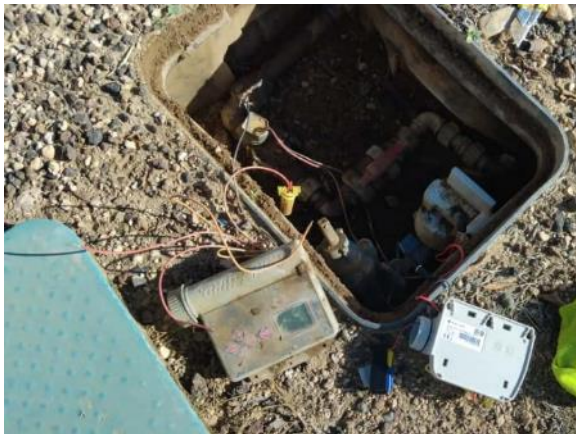
Vial ppal. dcha. junto Escuela Golf (cambio programador RainBird roto por uno Solem Nuevo)
