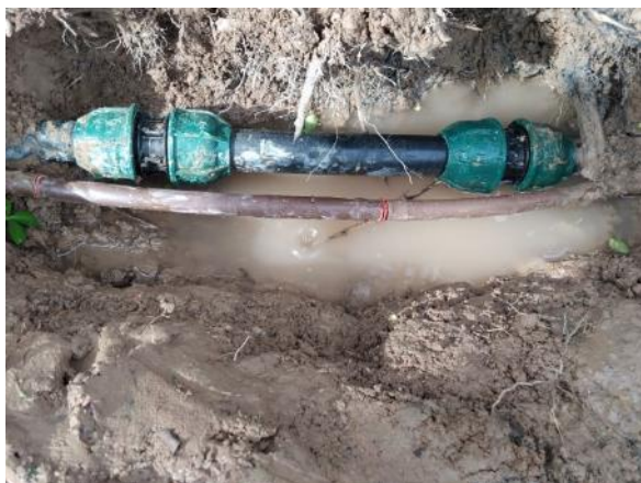
Vial Ppal. dcha. altura mantenimiento (0,5 ml PE Ø32 y 2 enlaces)
