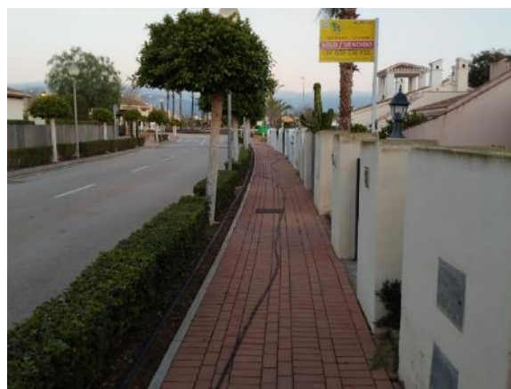
Phase 2 - Bélgica St. Num. 29-21, 64-40 y 72-64 (930 ml PE Ø16 and 37 links)
