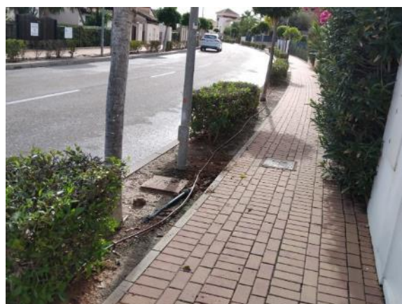
Phase 2 - Bélgica St. Num. 29-21, 64-40 y 72-64 (930 ml PE Ø16 and 37 links)
