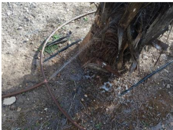
Fase 6 Zona B - Reparaciones varias (4 ml PE Ø16 y 8 enlaces)
