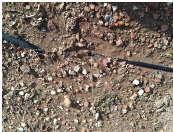
Fase 6 Zona B - Reparaciones varias (4 ml PE Ø16 y 8 enlaces)
