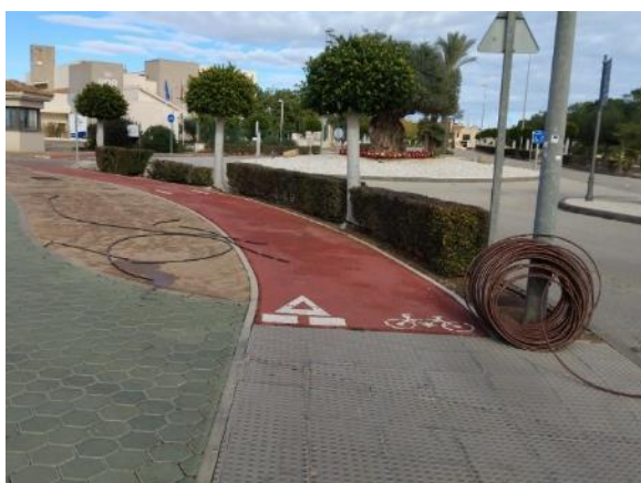
Vial Ppal. - Desde Caseta Ventas hasta Rot. Grava Negra (870 ml PE Ø16 y 31 enlaces)
