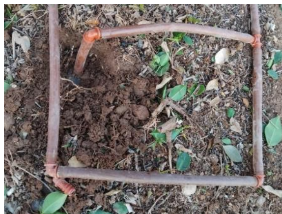
C/ Canadá junto parking 1 (1 ml PE Ø16 y 1 codo)
