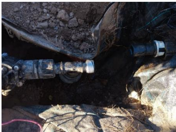
Vial ppal. izq. altura hotel (cambio electroválvula)
