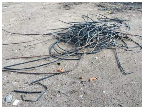
Fase 1 - C/ Austria N os 5-7 (35 ml PE Ø16 y 2 enlaces)
