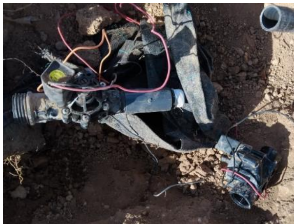
Vial ppal. izq. altura hotel (cambio electroválvula)
