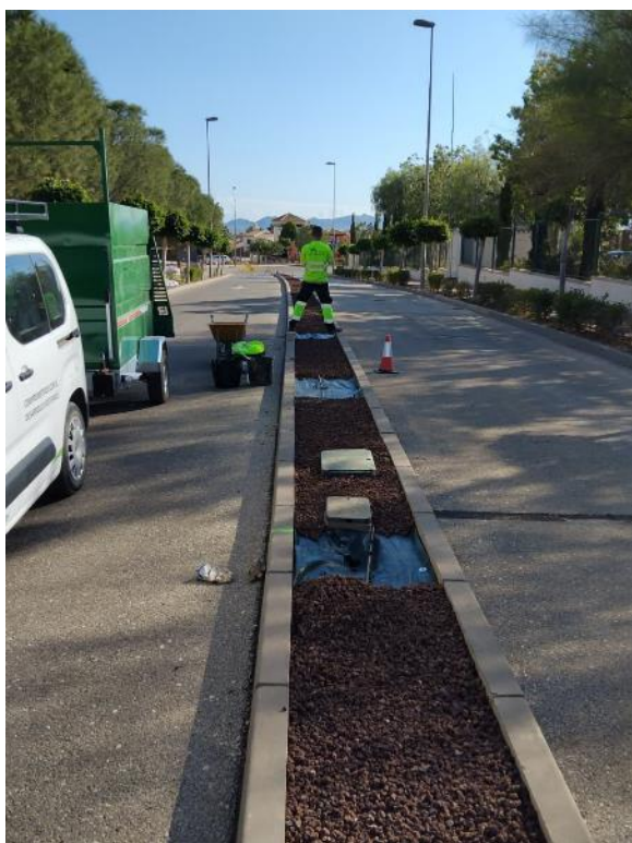
Vial entrada Fase 8 (reposición línea riego)
