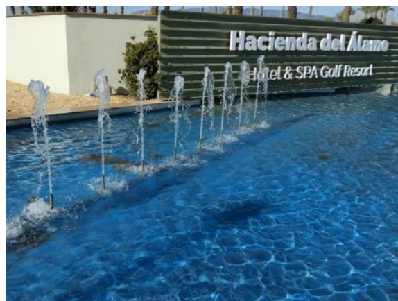
Fuente de la entrada (limpieza acumulación de hojas zona bombas)
