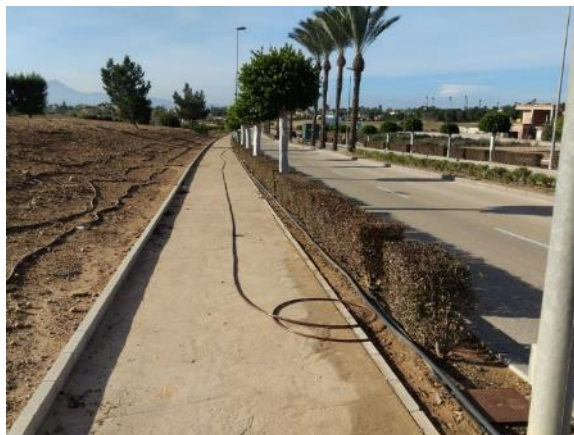
Vial Ppal. - Desde entrada Zona Mantenimiento hasta rotonda Fase 1 (1.200 ml PE Ø16 y 26 enlaces)
