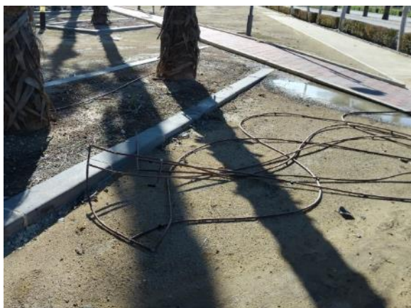
Fase 6 Olivos - Reposición líneas de goteo (400 ml PE Ø16 y 12 enlaces)
