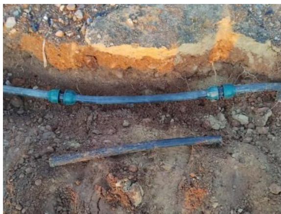
Fase 6 Olivos - Parterre trasero palmeras (1 ml PE Ø32 y 2 enlaces)
