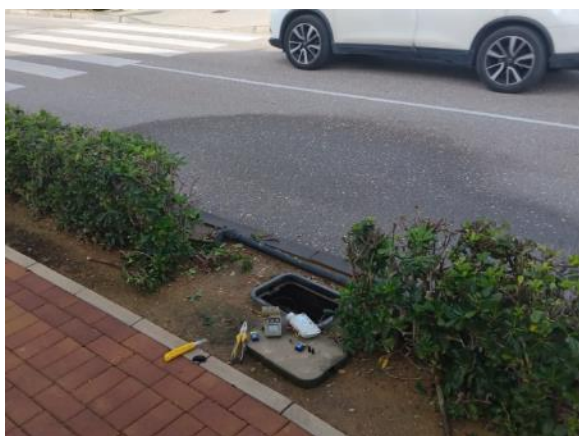
Frente a C/ Austria, 7 (cambio programador Solem 1 estación)
