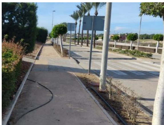
Vial Ppal. - Desde entrada Zona Mantenimiento hasta rotonda Fase 1 (1.200 ml PE Ø16 y 26 enlaces)
