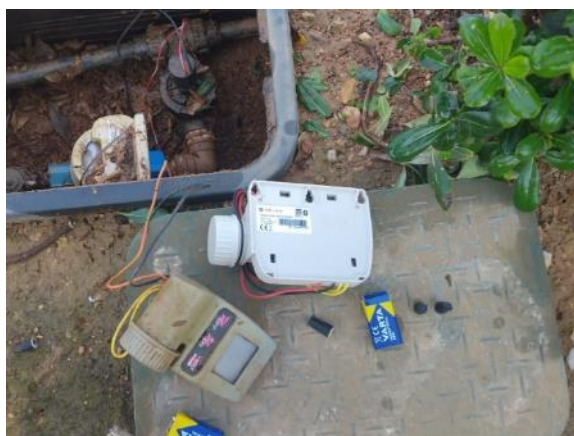
Frente a C/ Austria, 7 (cambio programador Solem 1 estación)
