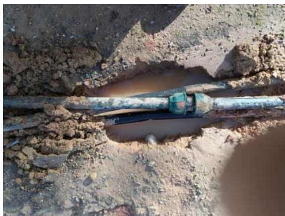
Fase 6 Olivos - Reposición parcial tubería de reparto (100 ml PE Ø32 y 6 enlaces)
