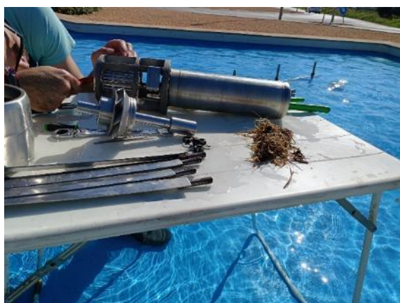
Fuente entrada - Limpieza por acumulación de residuos en tobera cuerpo hidráulico
