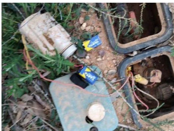
C/ Brasil, 30 - Jardín rotonda (cambio pila programador)
