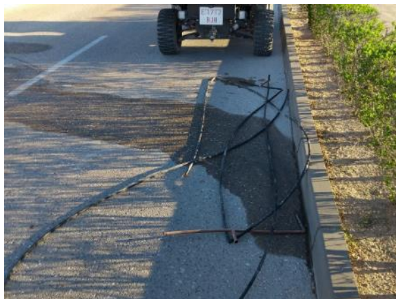
Vial Ppal. mediana (20 ml PE Ø16 y 2 enlaces)
