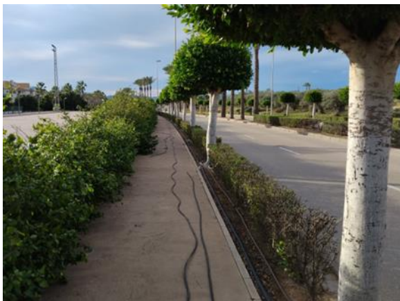
Vial Ppal. ambos lados - Desde rotonda Fase 1 hasta rotonda Fase 6 (950 ml PE Ø16 y 10 enlaces)
