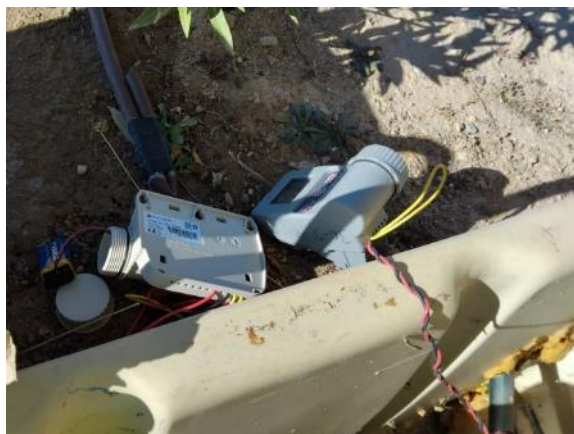
Vial Ppal. mediana - frente Mantenimiento (cambio programador Rain Bird por Solem de 1E)
