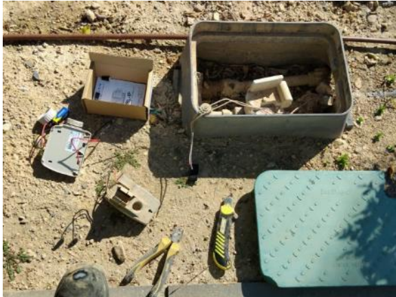
Fase 2 - C/ Bahamas, 32 (cambio programador Solem 1E)
