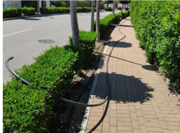
Fase 2 - C/ Bélgica 35-33 (reposición 33 ml PE Ø32, 2 enlaces)
