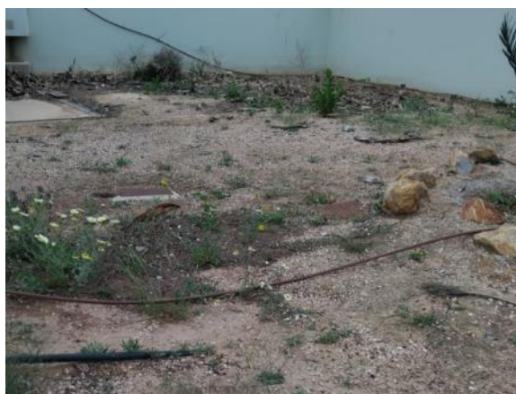
Jardín detrás Vigilantes - Reposición línea goteo (180 ml PE Ø16, 44 goteros)
