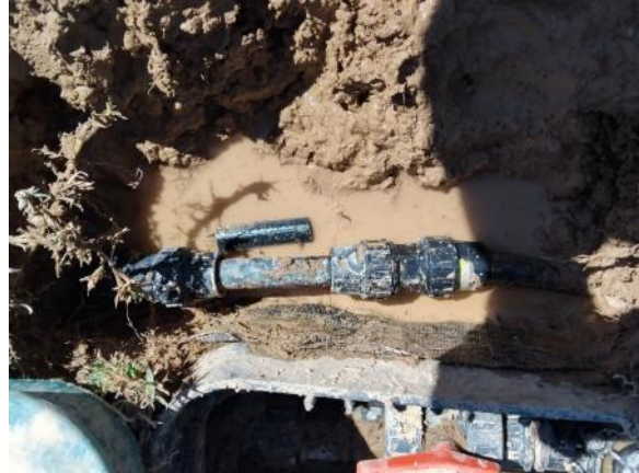
Parterre entrada dcha. - Cipreses (0,5 ml PE Ø20 y 2 enlaces)
