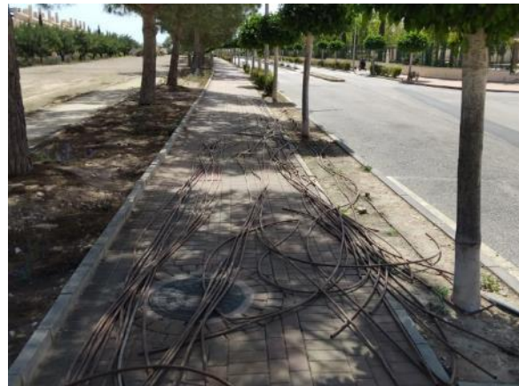
Pueblo Español - Reposición línea goteo entrada (390 ml PE Ø16, 6 enlaces)
