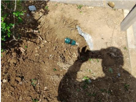
Vial ppal. - Rotura por raíces frente Hotel (35 ml PE Ø32, 3 enlaces)
