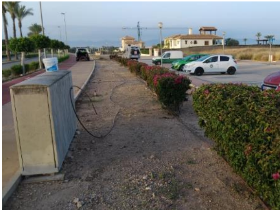
Vial ppal. - Parterre junto parking Casa Club (reposición 58 ml PE Ø16, 4 enlaces)
