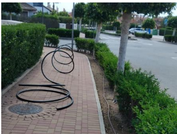
Vial ppal. - Parterre junto parking Casa Club (reposición 58 ml PE Ø16, 4 enlaces)
