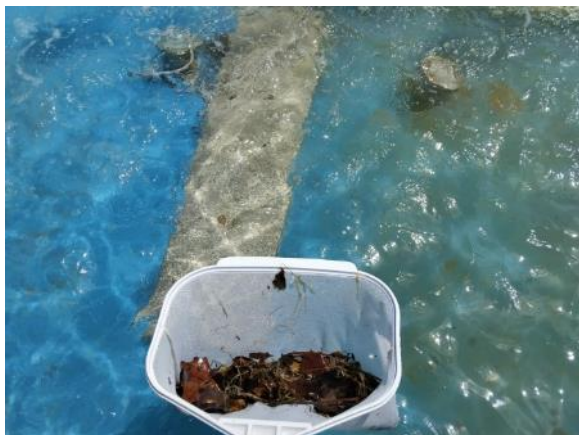
Fuente Entrada - Limpieza acumulación hojas en zona bombas y flotantes
