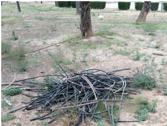
Jardín detrás Vigilantes - Reposición línea goteo (180 ml PE Ø16, 44 goteros)
