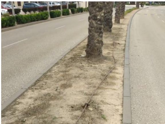
Vial ppal. mediana de Casa Club a rotonda Fase 1 - Reposición línea goteo (240 ml PE Ø16, 16 enlaces)
