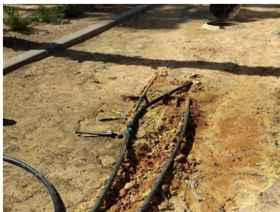
Phase 6 - Olivos B (3 ml PE Ø32, 2 link)
