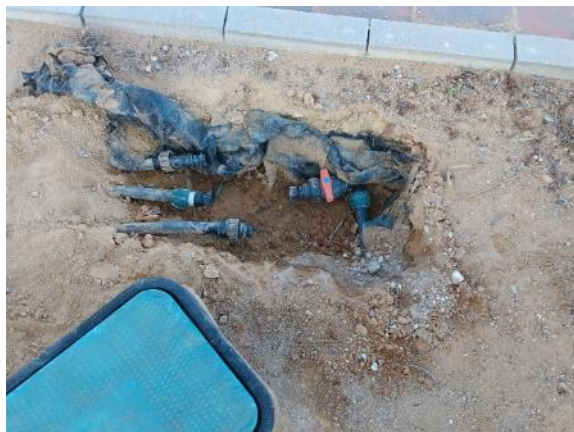
Fase 6 - Olivos B (cambio programador Rain Bird por Solem 2E, 2 electroválv y 3 pilas 9V)
