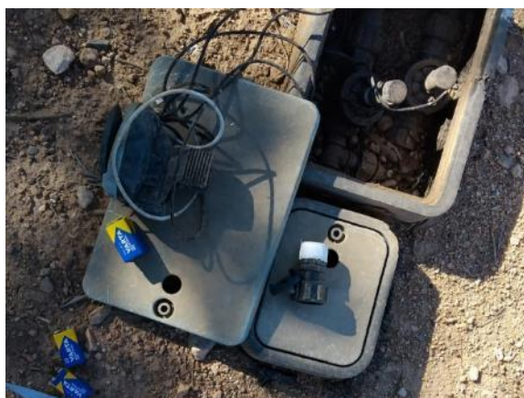
Fase 6 - Olivos B (cambio programador Rain Bird por Solem 2E, 2 electroválv y 3 pilas 9V)
