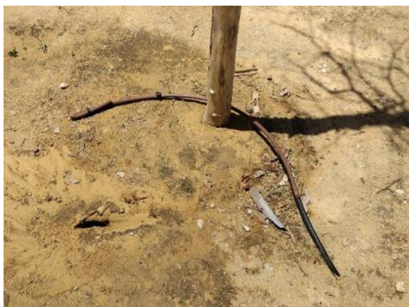
Fase 6 - Jardín Olivos B (reparación anillo 2 ml PE Ø16, 2 enlaces, 2 goteros)
