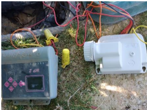
Entrada - Jardín por Cuadros (reposición 1 programador Rain Bird por Solem 2E)
