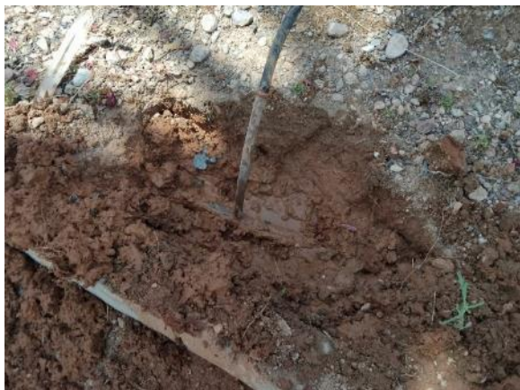
Fase 6 - Jardín C/ Guinea (reparación fuga 0,5 ml PE Ø16, 2 enlaces)
