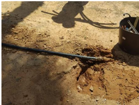
Entrada - Jardín por Cuadros (reposición 3 ml PE Ø32, 2 enlaces)
