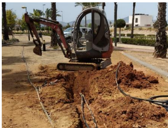
Fase 6 - Olivos A (reparación tubería 10 ml PE Ø32, 4 enlaces)
