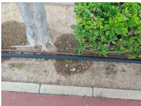
Vial Ppal. - Jardín C/ Vistas Green (reposición 70 ml PE Ø16, 6 enlaces)
