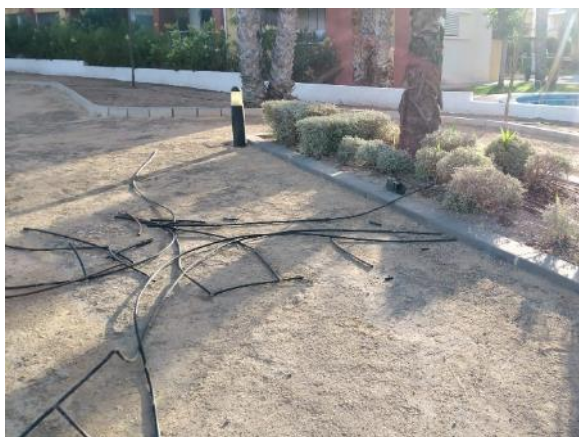
Fase 6 - Olivos A (reparación tubería rajada vieja 23 ml PE Ø16, 6 enlaces)
