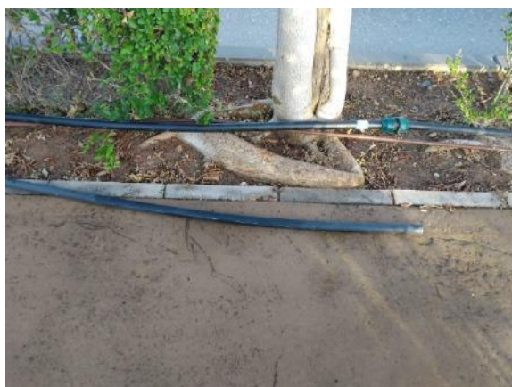
Vial Ppal. - Pistas Dep. (reparación 2 ml PE Ø32, 2 enlaces)
