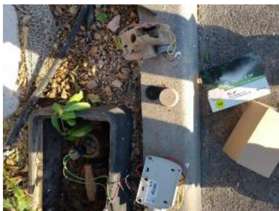
Fase 1 - C/ Alemania (reposición 1 programador Solem 1E)
