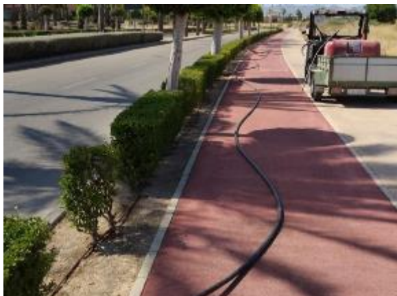
Vial Ppal. Izq. – Frente a Olivos A (reparación tubería rajada vieja 40 ml PE Ø32, 2 enlaces)
