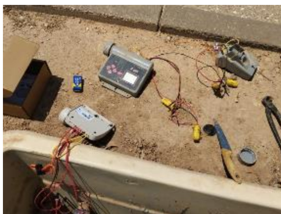
Vial Ppal. (mediana) - frente Campo fútbol (reposición 1 programador Solem 4E)
