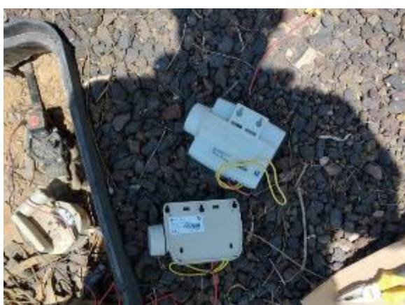
Fase 1 - C/ Alemania (reposición 2 programadores Solem 1E)
