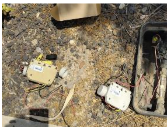
Fase 1 - C/ Alemania (reposición 2 programadores Solem 1E)
