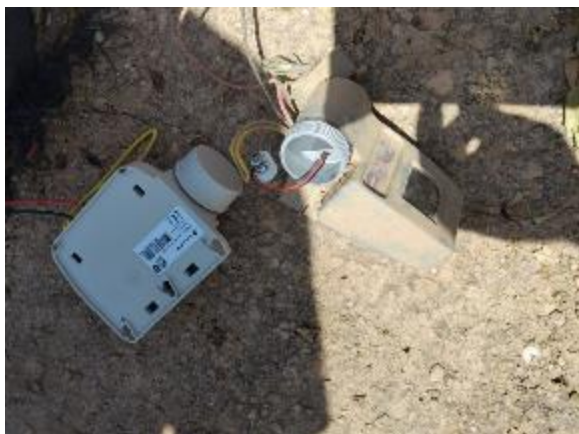
Pueblo Español - C/ Lituania (reposición 1 programador Solem 1E, 250 ml PE Ø16 y 12 enlaces)
