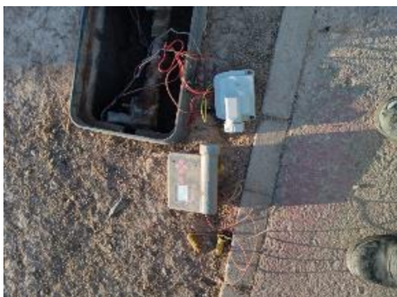
Vial Ppal. - entre Olivos y EUM (reposición 1 programador Solem 2E)
