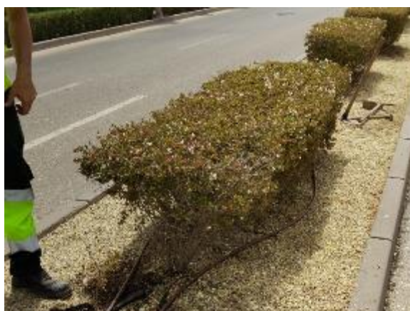
Vial Ppal. (mediana) - de garita a Olivos (reposición 70 ml tubería PE Ø32 y 2 enlaces)
