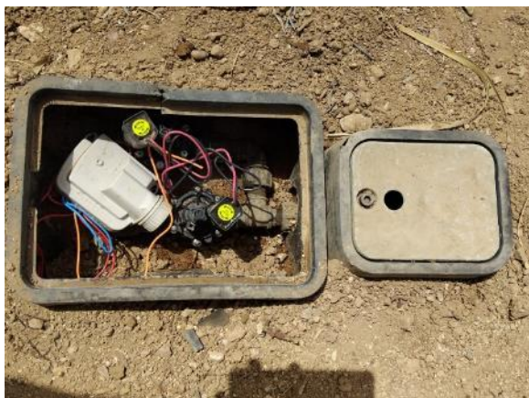
Fase 6 - Olivos B (reposición 1 programador Solem 2E y 2 electroválvulas 1")
