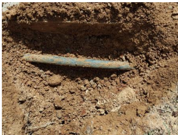
Fase 6 - Jardín Trasero (reparación tubería 1 ml PE Ø32, 2 enlaces)
