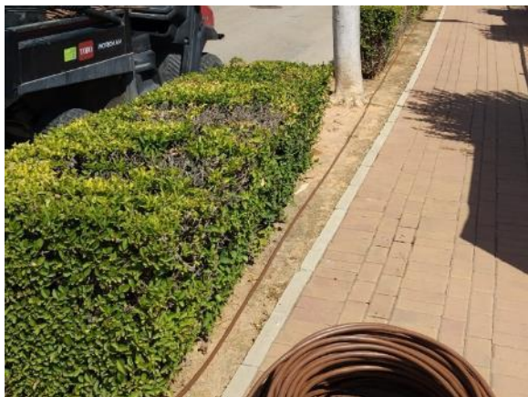
Fase 2 - C/ Bahamas 34 a 48 (reposición tubería 90 ml PE Ø16, 7 enlaces)
