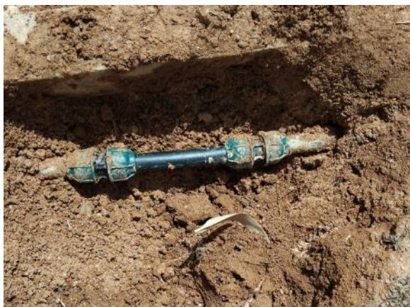
Fase 6 - Jardín Trasero (reparación tubería 1 ml PE Ø32, 2 enlaces)
