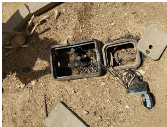
Fase 6 - Olivos B (reposición 1 programador Solem 2E y 2 electroválvulas 1")
