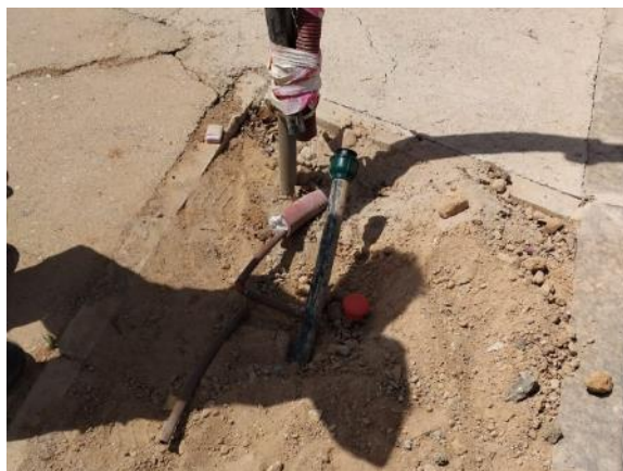
Fase 7 Oasis - Paso hacia Nuevas Viviendas (colocación 2 tapones Ø32, tubería 12 ml PE Ø16, 2 enlaces)
