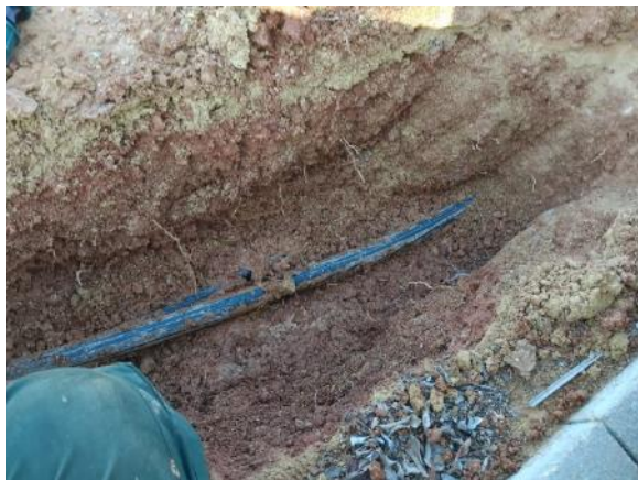
Fase 6 - Olivos B (reparación 0,5 ml PE Ø32, 2 enlaces)
