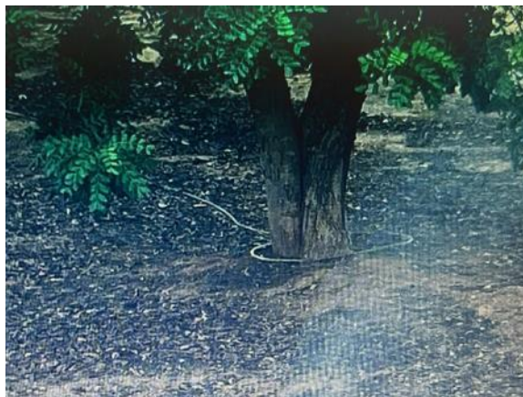
Fase 6 - C/ Guinea, jardín algarrobos (reparación 2 ml PE Ø32, 2 enlaces)
