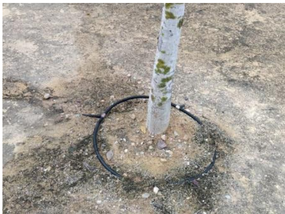
Avda. Bélgica - Izq. entrada (reparación 0,5 ml PE Ø16, 1 enlace)
