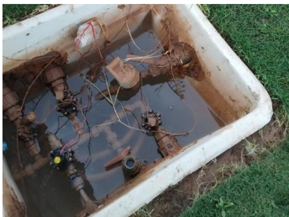
Entrada - Rotonda (reparación 0,5 ml PE Ø50, 1 codo)
