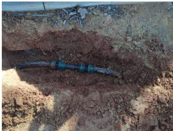
Fase 6 - Olivos B (reparación 0,5 ml PE Ø32, 2 enlaces)
