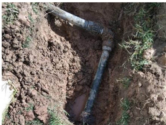
Entrada - Rotonda (reparación 0,5 ml PE Ø50, 1 codo)
