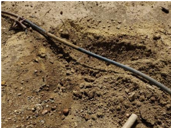
Fase 6 - C/ Guinea (reparación 0,5 ml PE Ø16, 2 enlaces)
