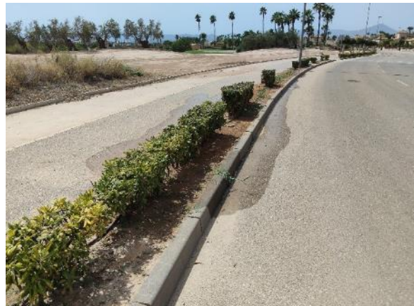
Fase 1 - Vial B (reparación tubería 1 ml PE Ø16, 2 enlaces)
