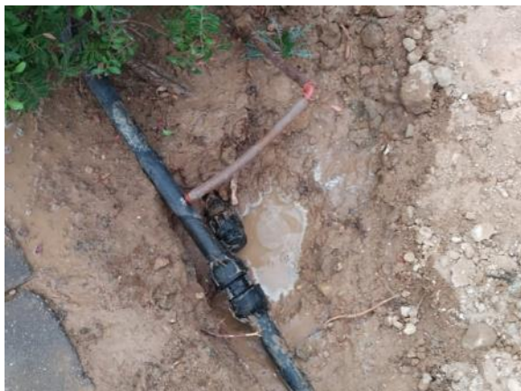
Fase 7 - Oasis (reparación 1 ml PE Ø32, 1 enlace y 2 tapones)
