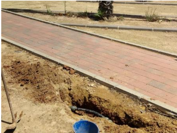
Fase 6 - Jardín Olivos B (reparación tubería 1 ml PE Ø32, 2 enlaces)
