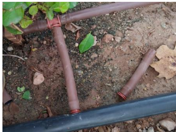
Vial Ppal. (dcha.) - Frente Campo Fútbol (reparación 0,5 ml PE Ø16, 1 enlace)
