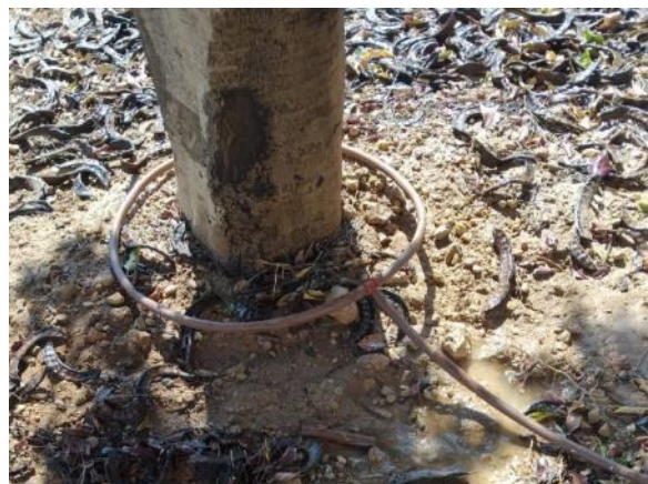
Fase 6 - C/ Guinea (reparación 1 ml PE Ø16, 1 enlace T)
