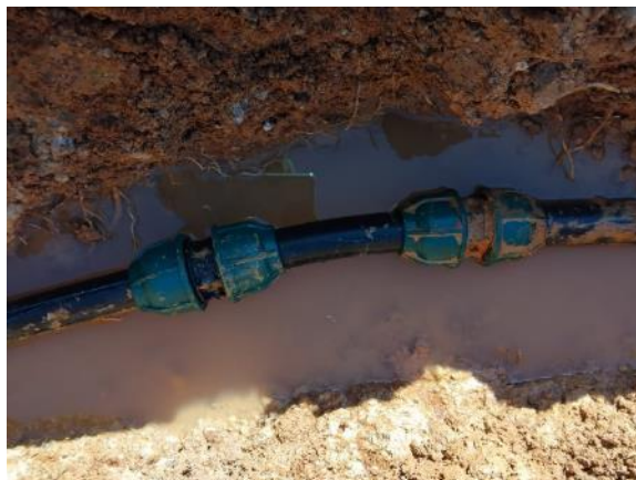
Phase 6 - Olivos B (repair 0.5 lm PE Ø32, 2 links)
