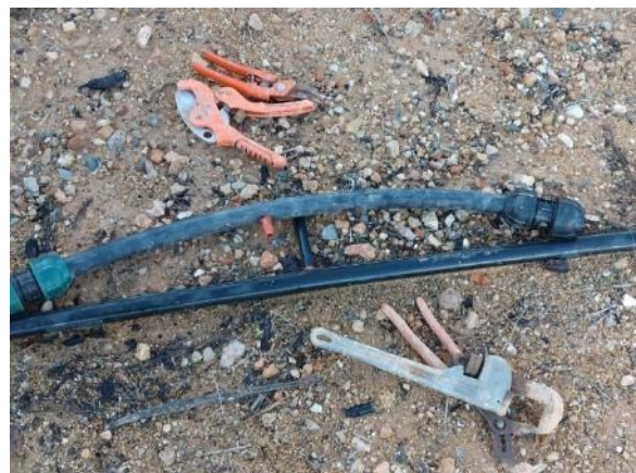
Pueblo Español - Garden/pool area (repair 1 lm PE Ø32, 2 links)
